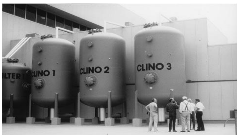
Εικόνα 12. Στήλες κλινοπτιλόλιθου από εργοστάσιο καθαρισμού νερού στο Deaver, CO.
